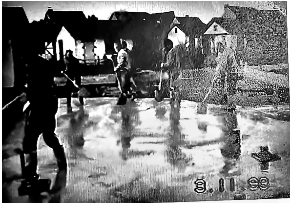
03.11.1993 – die Bodenplatte ist gegossen.
