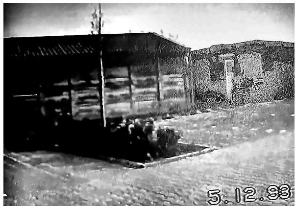
05.12.1993 – Rohbau, daneben noch der alte Holzschuppen.
