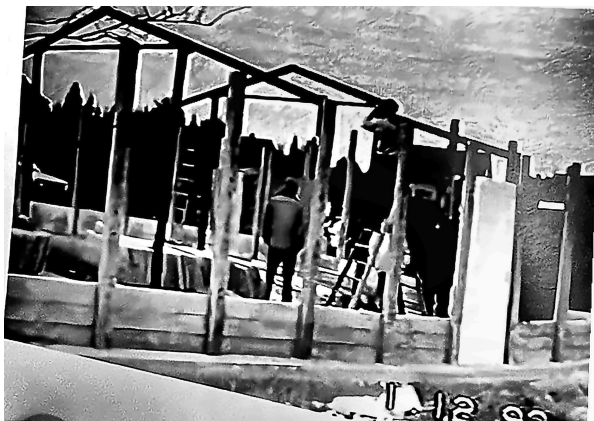
Foto: Adam Grauer. Der Rohbau nimmt Gestalt an, 01.12.1993.
