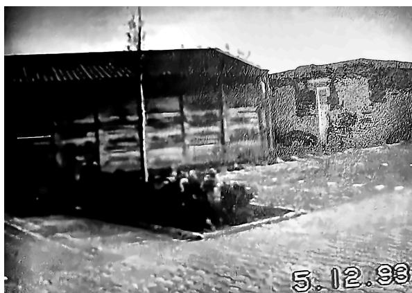
05.12.1993 – Rohbau, daneben noch der alte Holzschuppen.
