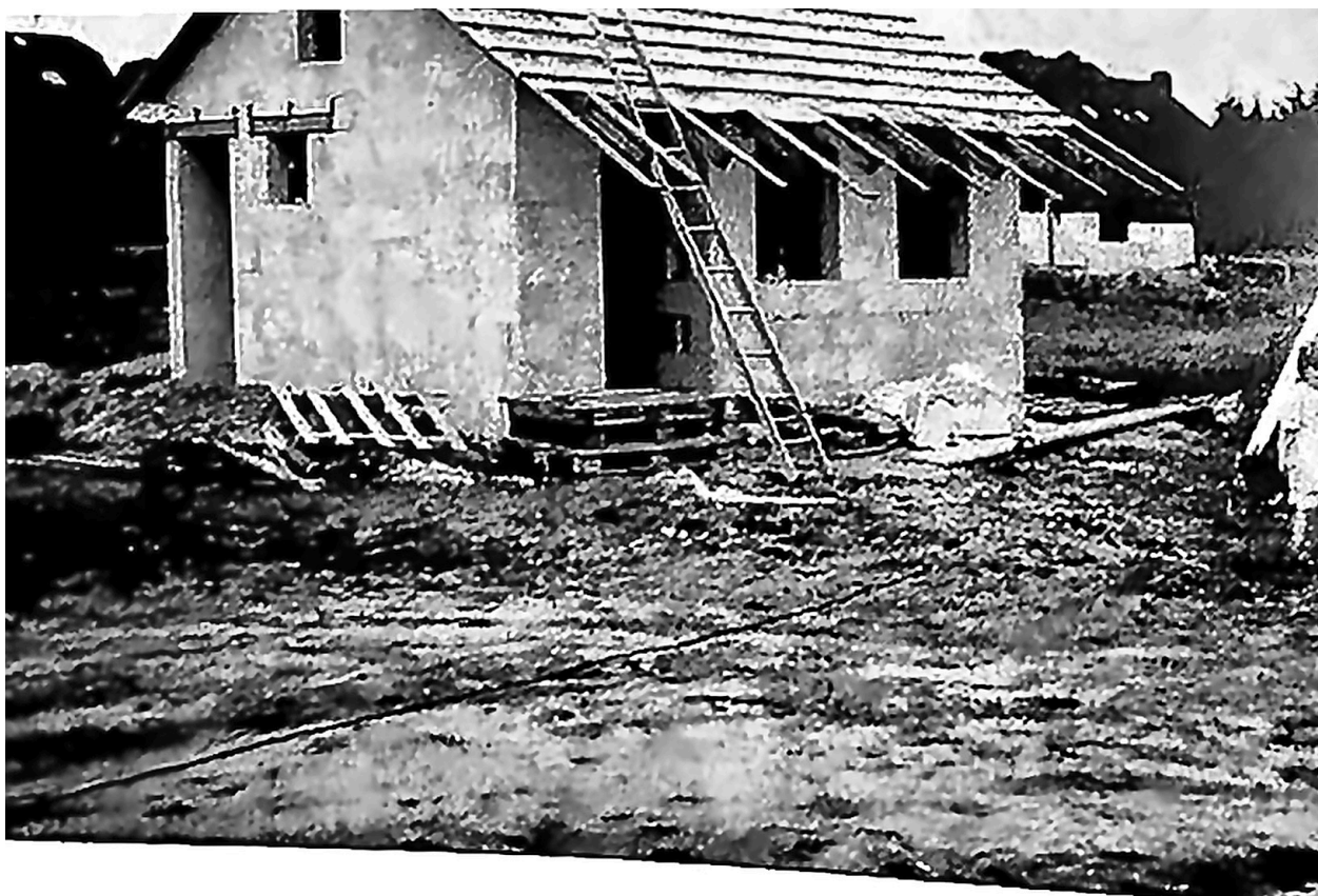
Der Dachstuhl ist gesetzt – ein Bauabschnitt aus dem persönlichen Album von Dietmar Falk.
