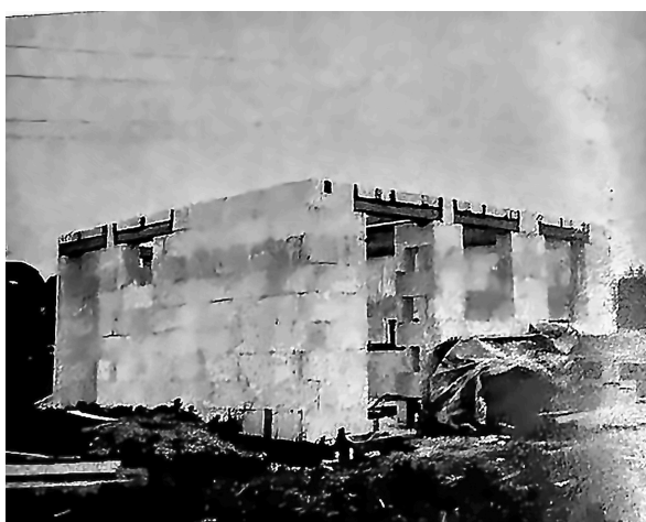
Baufortschritt eines Laubenbaus.
