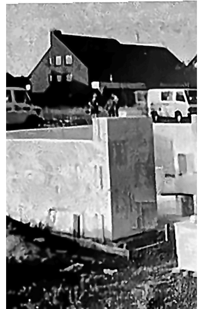
Foto: Dietmar Falk. Es geht voran auf der Baustelle.
