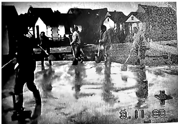
03.11.1993 – die Bodenplatte ist gegossen.
