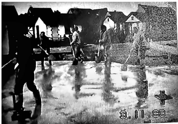
03.11.1993 – die Bodenplatte ist gegossen.
