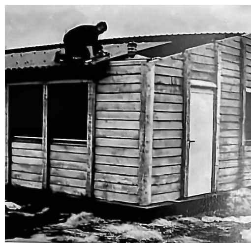
Foto: Kurtenbach / Ruhr-Nachrichten. Bis zur Fertigstellung dauert es nicht mehr lange.
