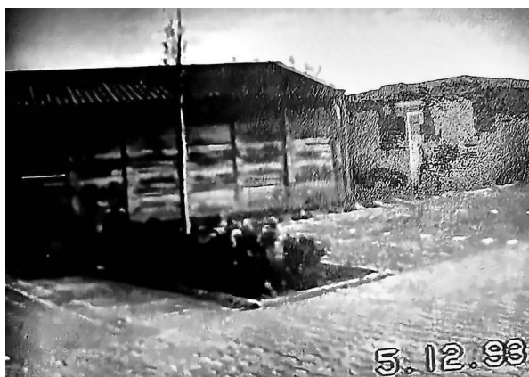
05.12.1993 – Rohbau, daneben noch der alte Holzschuppen.
