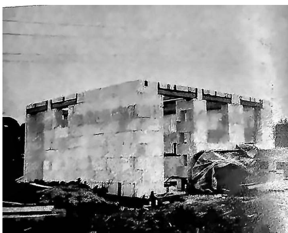
Baufortschritt eines Laubenbaus.
